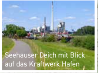
Seehäuser Deich mit Blick auf das Kraftwerk Hafencity
